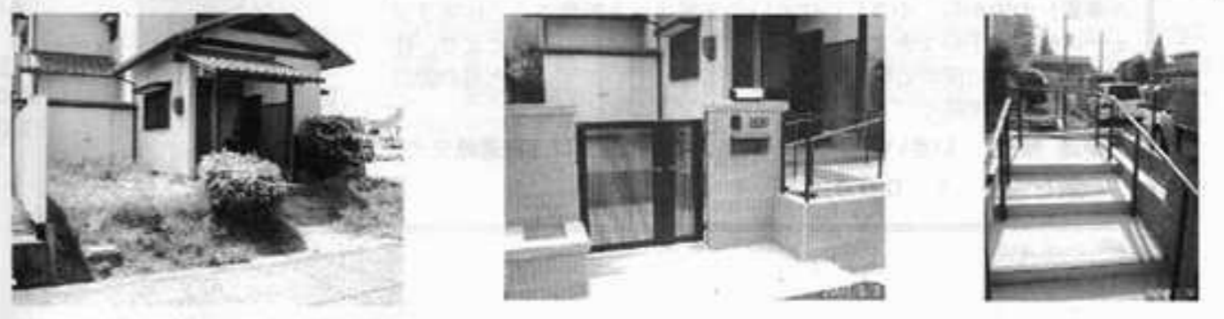
改修前アプローチ 改修後アプローチ 改修後アプローチ階段
