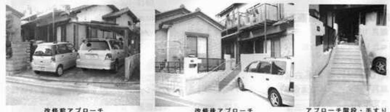
改修前アプローチ 改修後アプローチ アプローチ階段・手すり
