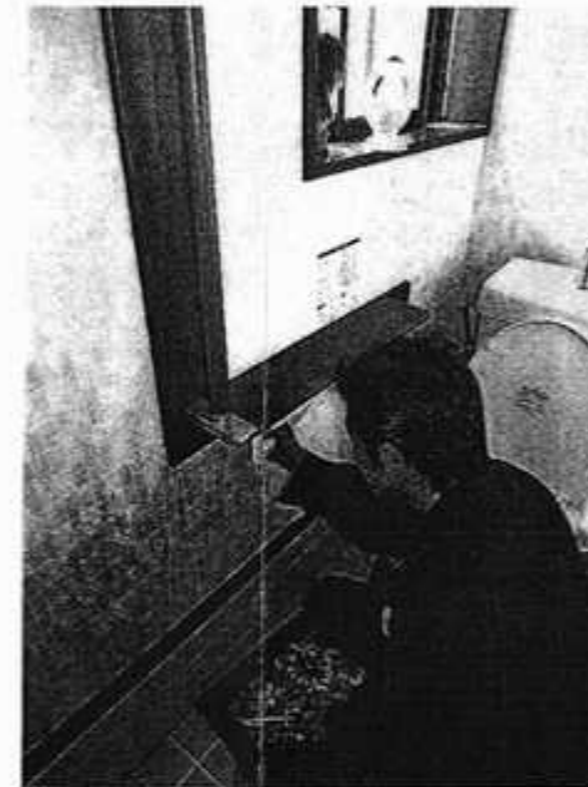
トイレに手すりを取り付ける業者。使いやすい位置かを確認することが大切—名古屋市内で
